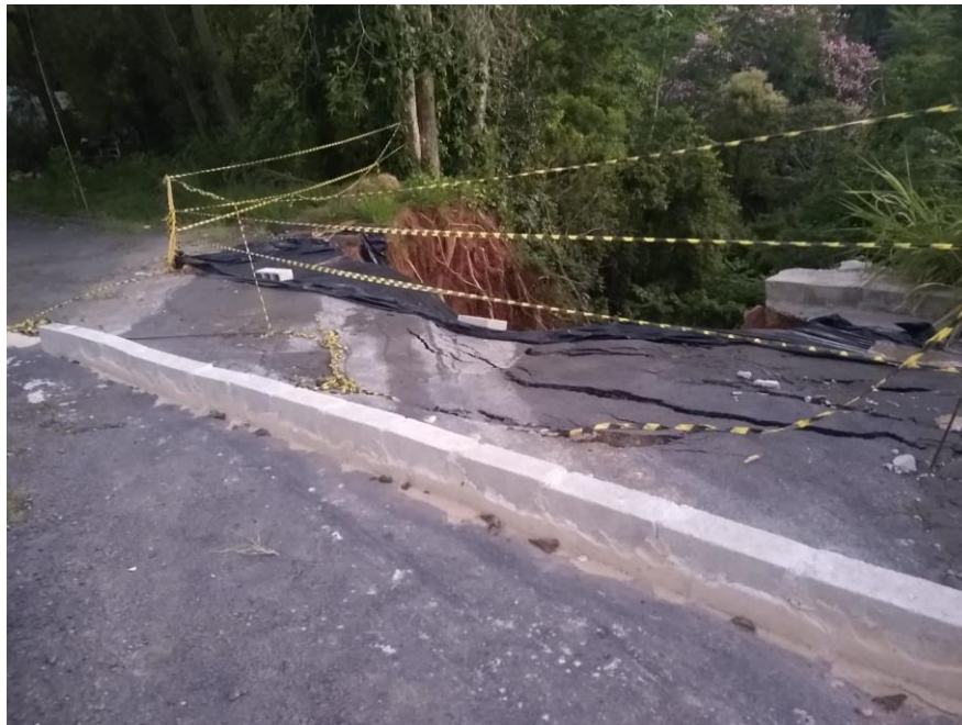
Figura 3 – Rua Francisco Pereira Mourão, proteção de talude com parede para desviar águas pluviais.
