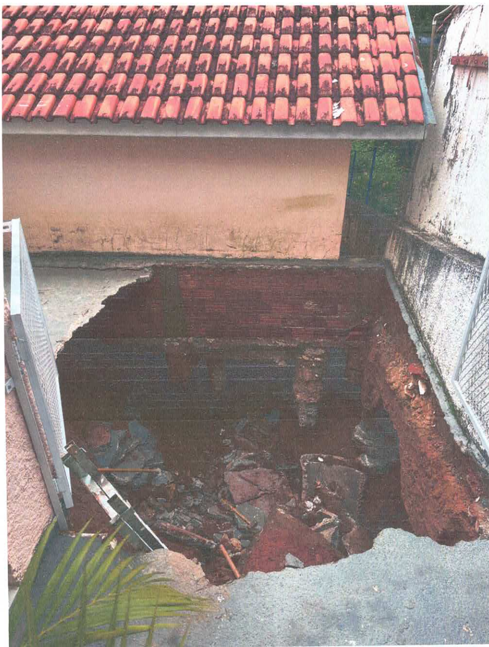
FOTO 01: Situação em 09 de novembro, após abertura quebra do piso de concreto.
