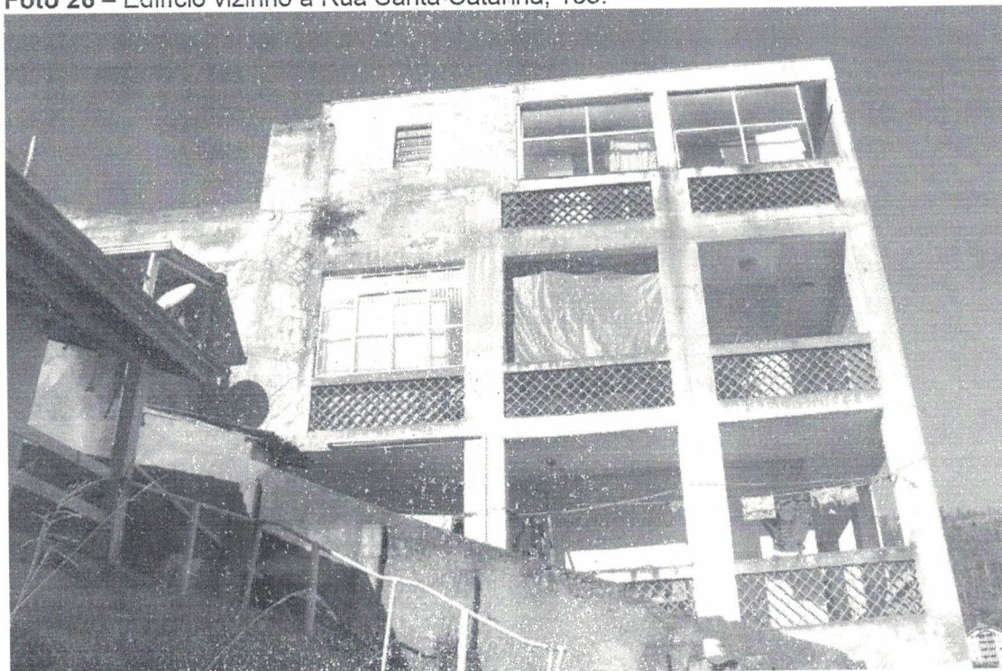
Foto 26 – Edifício vizinho à Rua Santa Catarina, 133.
