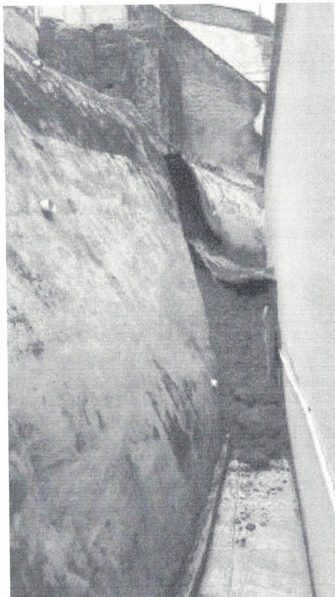
Figura 5 – Deslizamento de terra em talude da casa na Rua Santa Catarina, 133.
