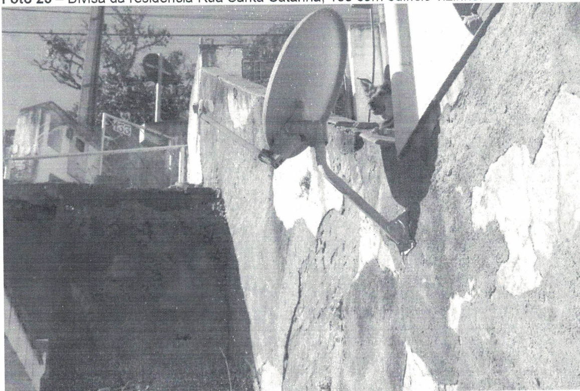
Foto 23 – Divisa da residência Rua Santa Catarina, 133 com edifício vizinho.
