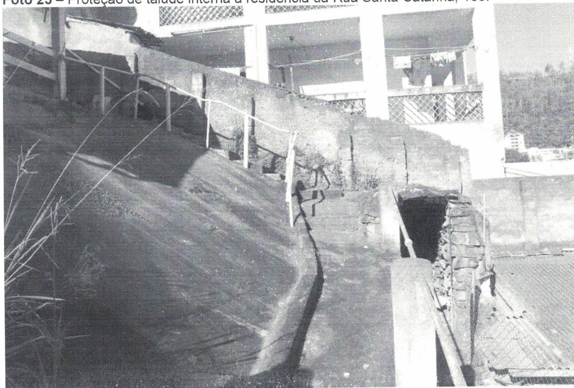
Foto 25 – Proteção de talude interna à residência da Rua Santa Catarina, 133.
