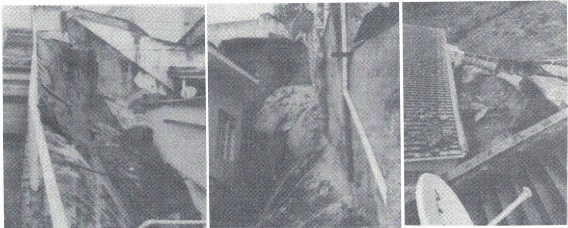
Figura 4 – Fotografias do deslizamento de terra na residência da Rua Santa Catarina, 133 em fevereiro de 2023.
