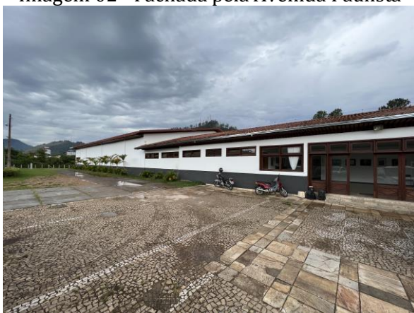
Imagem 04 - Prédio principal externo
