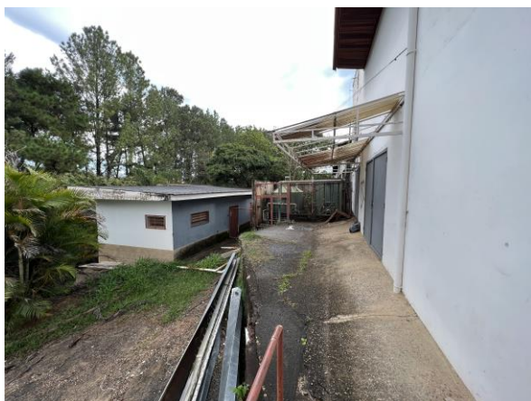
Imagem 08 – Cabine de força
