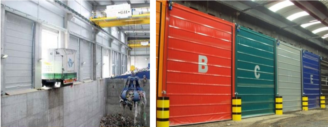
Figura 19 – Recepção de RSU - galpão cerrado e túneis para compostagem
