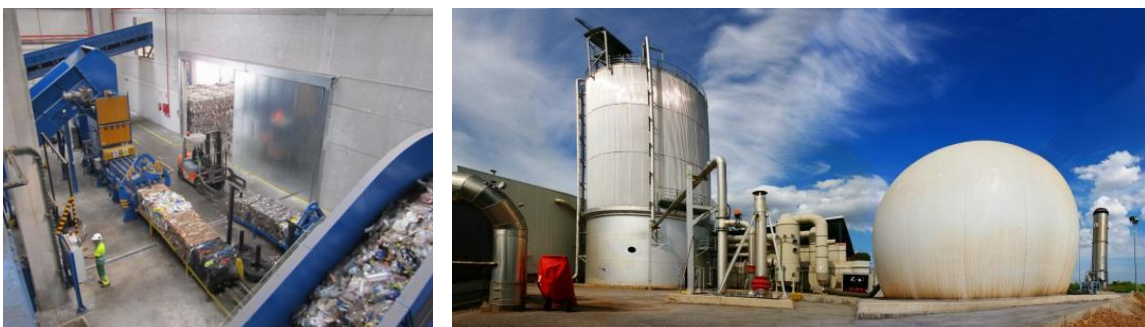
Figura 20 – TMB – segregação das embalagens e biodigestão seca dos orgânicos
